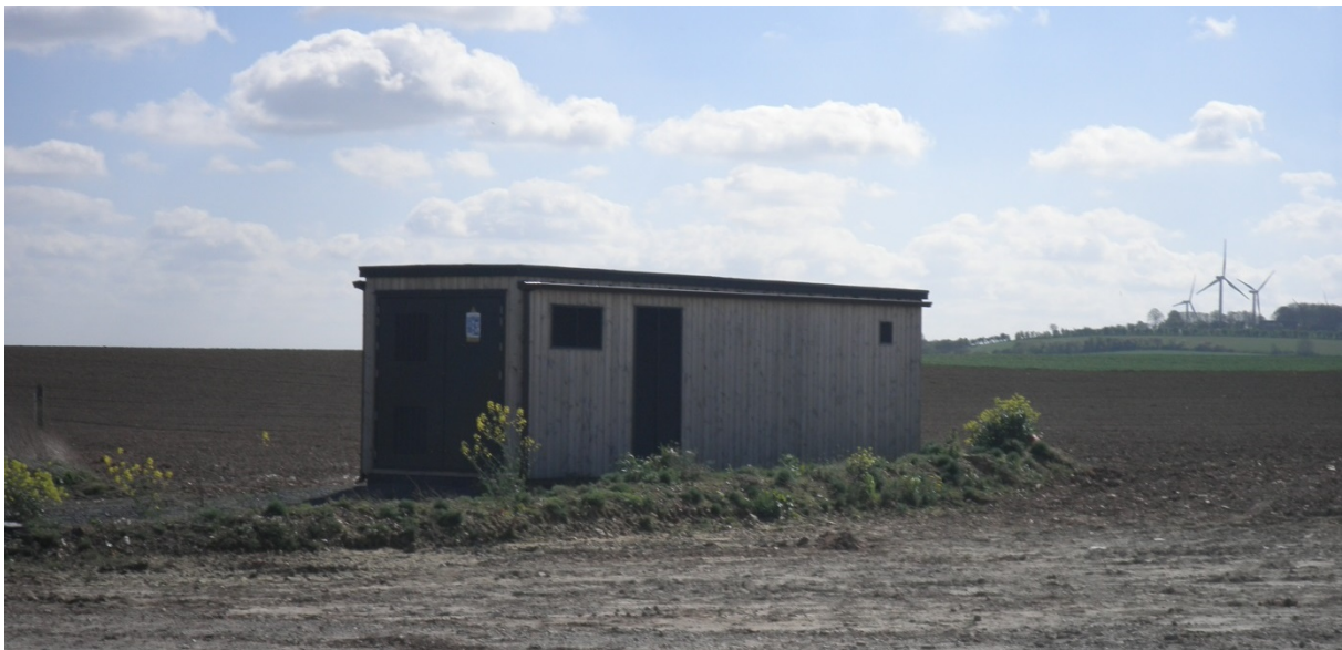
Exemple de poste de livraison qui sera mis en place
