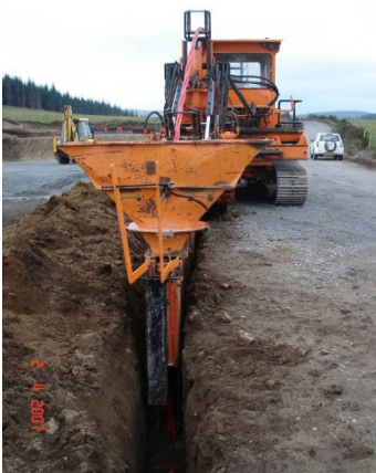
Réalisation de la tranchée et de la pose du câble simultanément
