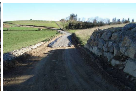
Mise en place du gravier
