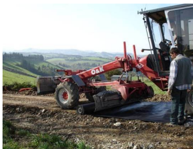
Pose du géotextile
